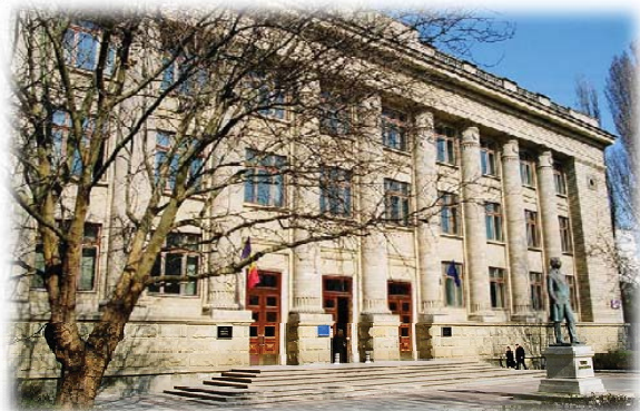
Blocul central al BNRM
